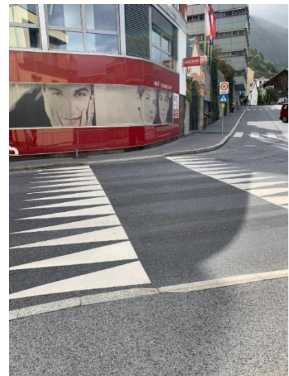
Schutzweg im Kurvenbereich durch Ordnungslinien „Haifischzähne“ ersetzt
